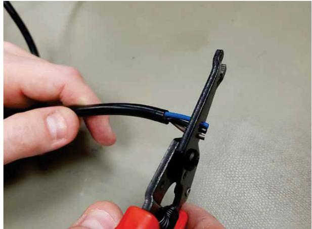
Die Adern abisolieren, wobei die in oben abgebildeten Schema angegebenen mm-Werte einzuhalten sind.
